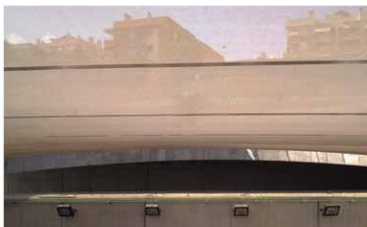
Dans un des tunnels de la nouvelle rocade de la commune, une couverture textile a été installée pour permettre la ventilation de l'installation. Ce tissu ajouré avec un revêtement en téflon présente un très bon comportement face à la salissure et une grande durée de vie.
