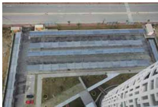
Cet édifice emblématique a été doté d'un parking extérieur avec une structure métallique et couverture textile type maille pour donner de l'ombre. Les portiques, situés à une distance de 5 m les uns des autres, ont des inclinaisons différentes, créant ainsi une couverture en forme de vague.
