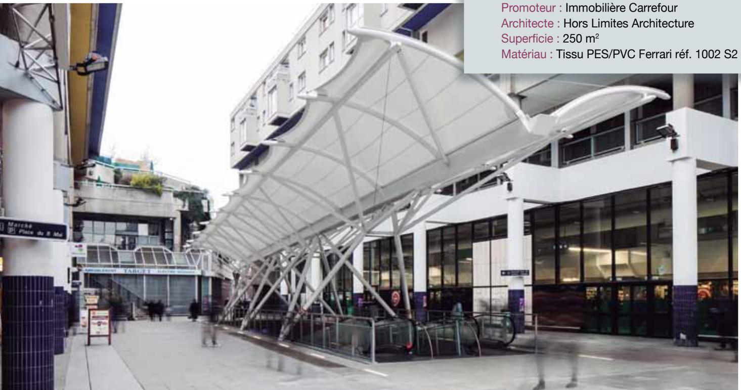
Une nouvelle couverture a été conçue pour la sortie piétons du parking souterrain du centre commercial. La structure s'appuie sur les deux lignes latérales de la cavité dans le sol et permet d'incorporer les escaliers mécaniques. La membrane textile, de deux pièces, suit la forme d'aile que décrivent les éléments métalliques.
