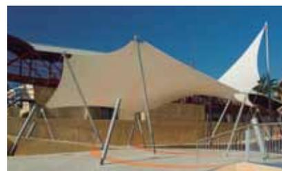
Les structures tendues possèdent leur propre technologie basée principalement sur le comportement du matériau. L'exigence d'une double courbure sur toute la surface de la membrane textile conditionne sa forme et, par conséquent, son aspect final. La capacité créatrice et les connaissances du concepteur, avec l'utilisation systématique de programmes informatiques, marqueront le résultat architectural définitif.
